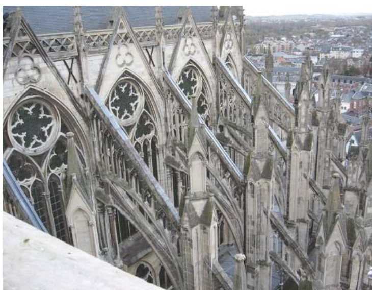
Kontrforslar və arkbutanlar sistemi. Amyen kafedralı. Fransa. 1220-1266
